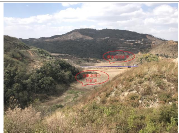
曹家沟、玉铜汞凹子尾矿库现状
