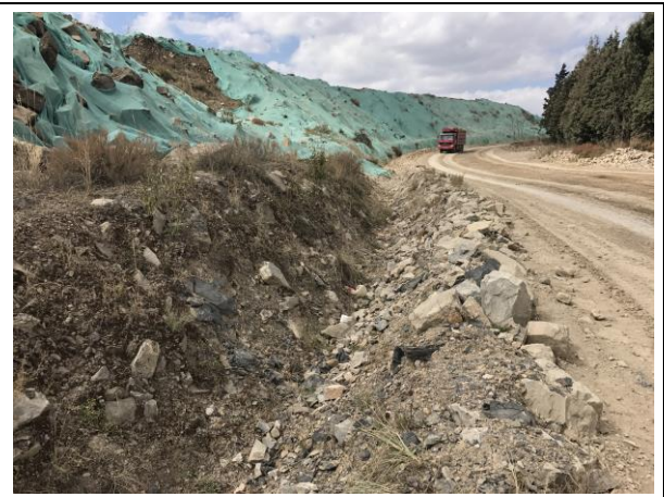
贫矿堆场截排沟
