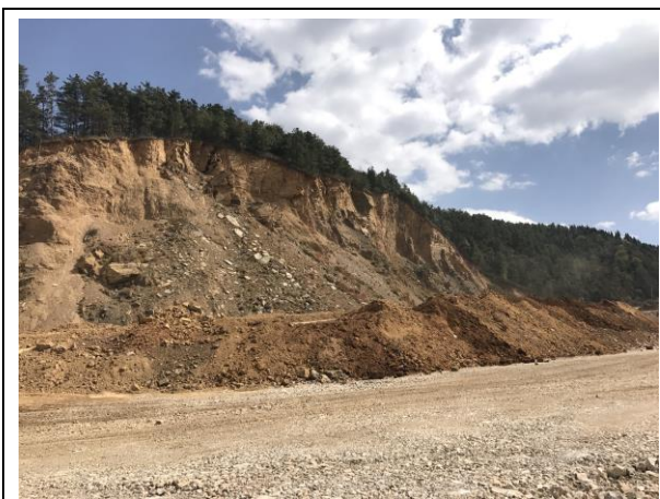
四采区复土整改区
