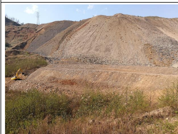
四采区排土场拦砂坝
