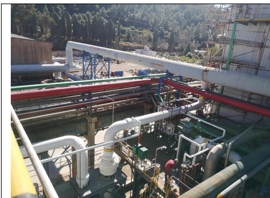
新增管道（红色蒸汽管，白色硫酸管）
