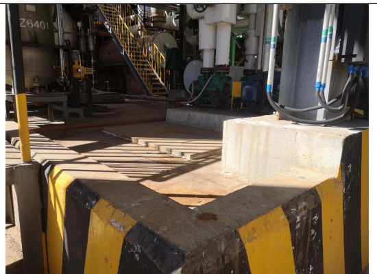
新增装置区围堰
